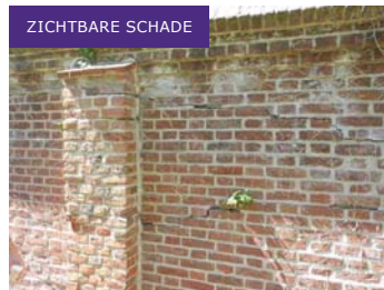
scheefstand &amp; scheurvorming
