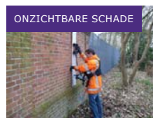
zorgvuldig radaronderzoek geeft inzicht in interne aantasting
