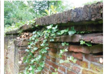
aangetaste rollaag
